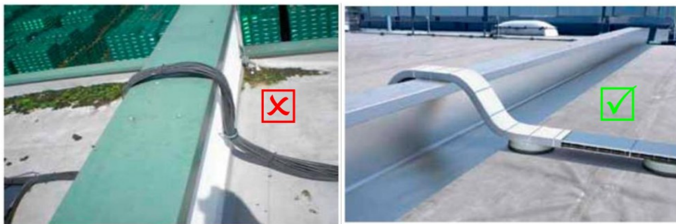
Slika 9: Primer neustrezne in ustrezne izvedbe prehoda preko požarnega zidu
